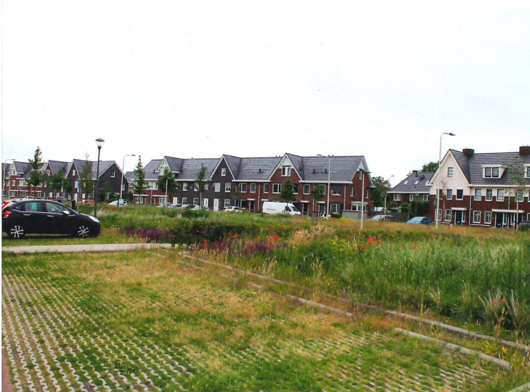
Op diverse plaatsen in de wijk is gekozen voor open grasbeton. Bij zware regenbuien kan het water makkelijker in de grond wegzakken, waardoor het riool wordt ontlast. Ook ogen de parkeerplekken groener, en loopt de begroeiing als het ware door in de openbare ruimte.
