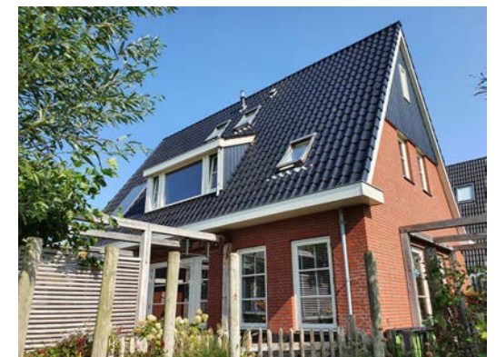
Woning vanaf de begane grond opgebouwd met houtsysteem
