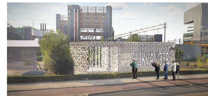
De Blikvanger, een gebouw dat geheel circulair wordt opgebouwd en demontabel is
